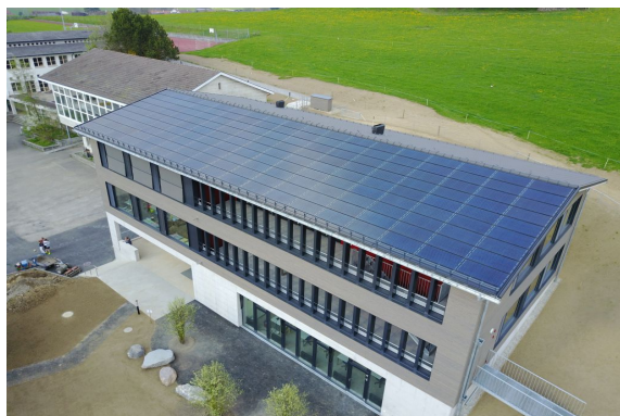
Anlage Rifferswil - seit Februar im Betrieb Drohnenaufnahme von D. Rösner
